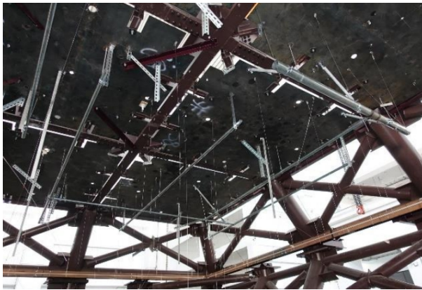
圖 3 斜撐組實際安裝情形
