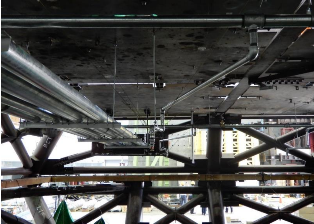
圖 6 管線安裝完成圖
