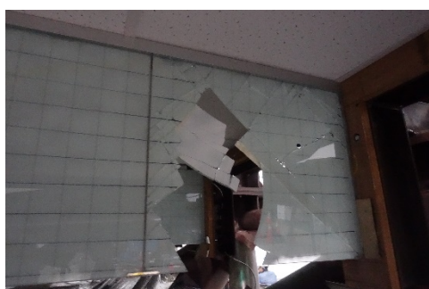
圖 14 A 試體西側玻璃損壞情形
