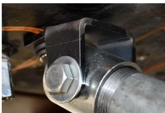
圖 13 主管斜撐變形
