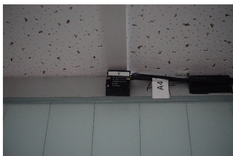
圖 7 安裝於防煙垂壁上軌道之加速規
