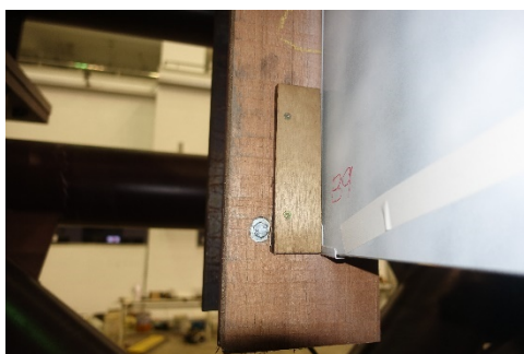
圖 10 試體端部填縫膠破壞後修補方式
